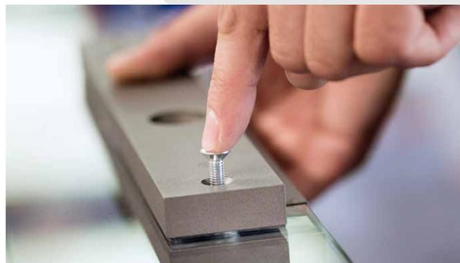
3/ Jedinica za zaključavanje postavlja se u pripremljeni utor. Staklo se opet štiti plastičnim razmaknicima i trakom od filca.
