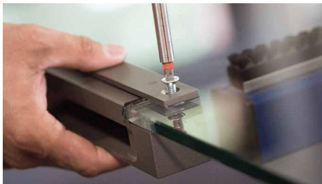
2/ Držać panta postavlja se u krilo staklenih vrata u kojem je pripremljen utor. Dostavljeni plastični razmaknici umeću se između krila vrata i metalnih sastavnica držača panta. Oni štite staklo i povećavaju trenje učvršćivanja.
