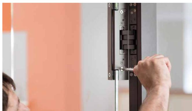
7a/ Pant se vijcima pričvrsti za držač. Tada se krilo vrata postavlja u pant uz pomoć alata za trodimenzionalno podešavanje.
