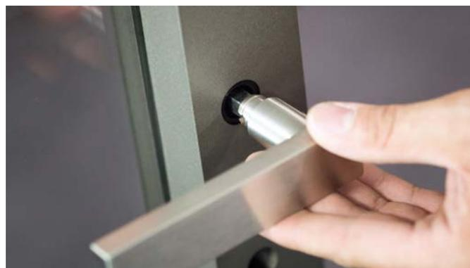
8/ Der Türgriff wird mit dem Schloss im Schlosskasten montiert.
