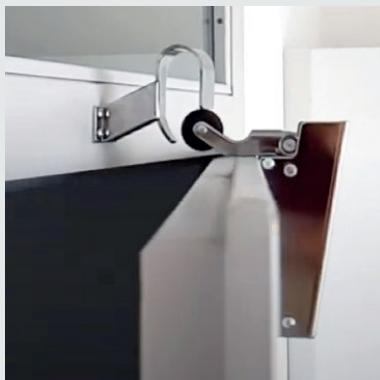
U pravilu se usporivači vrata postavljaju na sredinu gornjeg ruba vrata. Kuka se nalazi iznad, na okviru vrata. Pri otvaranju vrata kuka automatski gura kotačić prema dolje i na taj način zateže integriranu oprugu.
