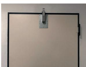
Protupožarna vrata u podzemnim garažama ili podrumima mogu pri zatvaranju jako lupati. Razlog tome je velika težina ili loše postavljen zatvarač vrata. Lupanje stvara buku i ometa sve stanovnike i ako se jedno krilo protupožarnih vrata zatvori, može se desiti da se drugo ne zatvori dobro i na taj način više ne štite od požara odnosno gube svoju funkciju. Taj problem se može riješiti sa usporivačem za protupožarna vrata.
