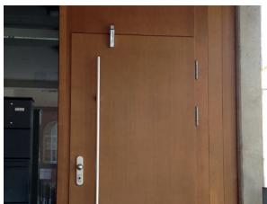
Zatvaranje vrata u kućama, stanovima, zgradama obično uzrokuje buku, pogotovo ako su opremljena sa gornjim zatvaračem vrata. A neka vrata se ne zatvore skroz i predstavljaju sigurnosni rizik. Usporivači uhvate vrata tik prije zatvaranja i povlače ih tiho i kontrolirano. Na taj način brinete o sigurnosti i miru svih stanovnika.
