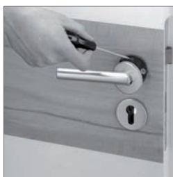
Verriegelungsposition des Schließers beachten. Madenschraube fest anziehen. Fertig.
