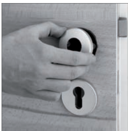
Einbau der Rosetten am Türblatt.
